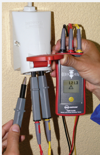
Überprüfung von Steckdosenverkabelung
