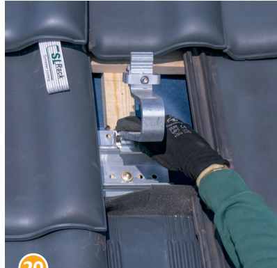
20 Dachhaken in Fuß einhängen.
