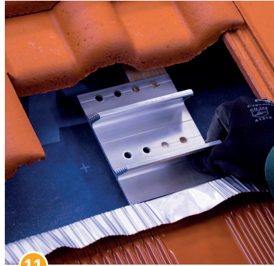
11 Fuß des Dachhakens auf dem Dachsparren ausrichten.
