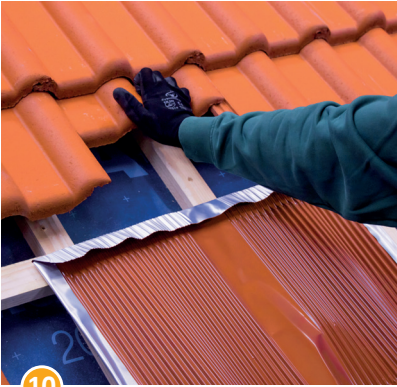
10 Dacheindeckung über Beta-Platte aufdecken.
