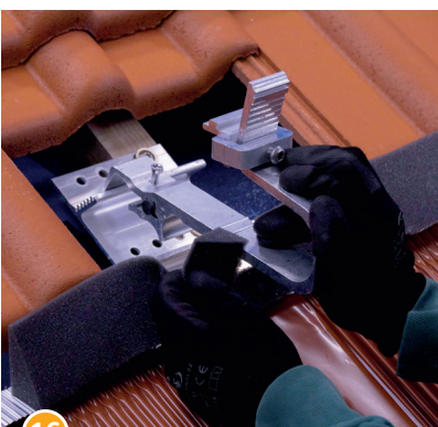
16 Dachhaken in Fuß einhängen.
