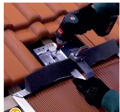
18 Position des Dachhaken durch Anziehen der Schraube fixieren (6 Nm).
